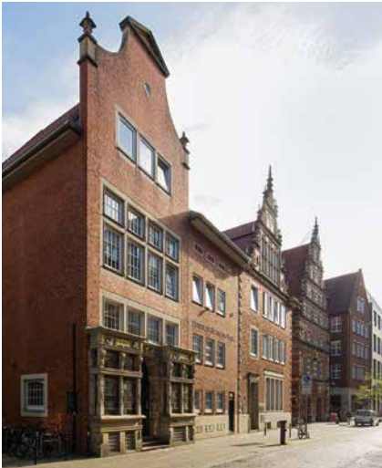
Standort Bremen (Essighaus)
